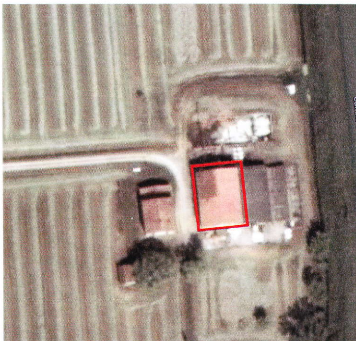
Figura 1: Vista aerea inquadramento fabbricato oggetto della presente perizia
