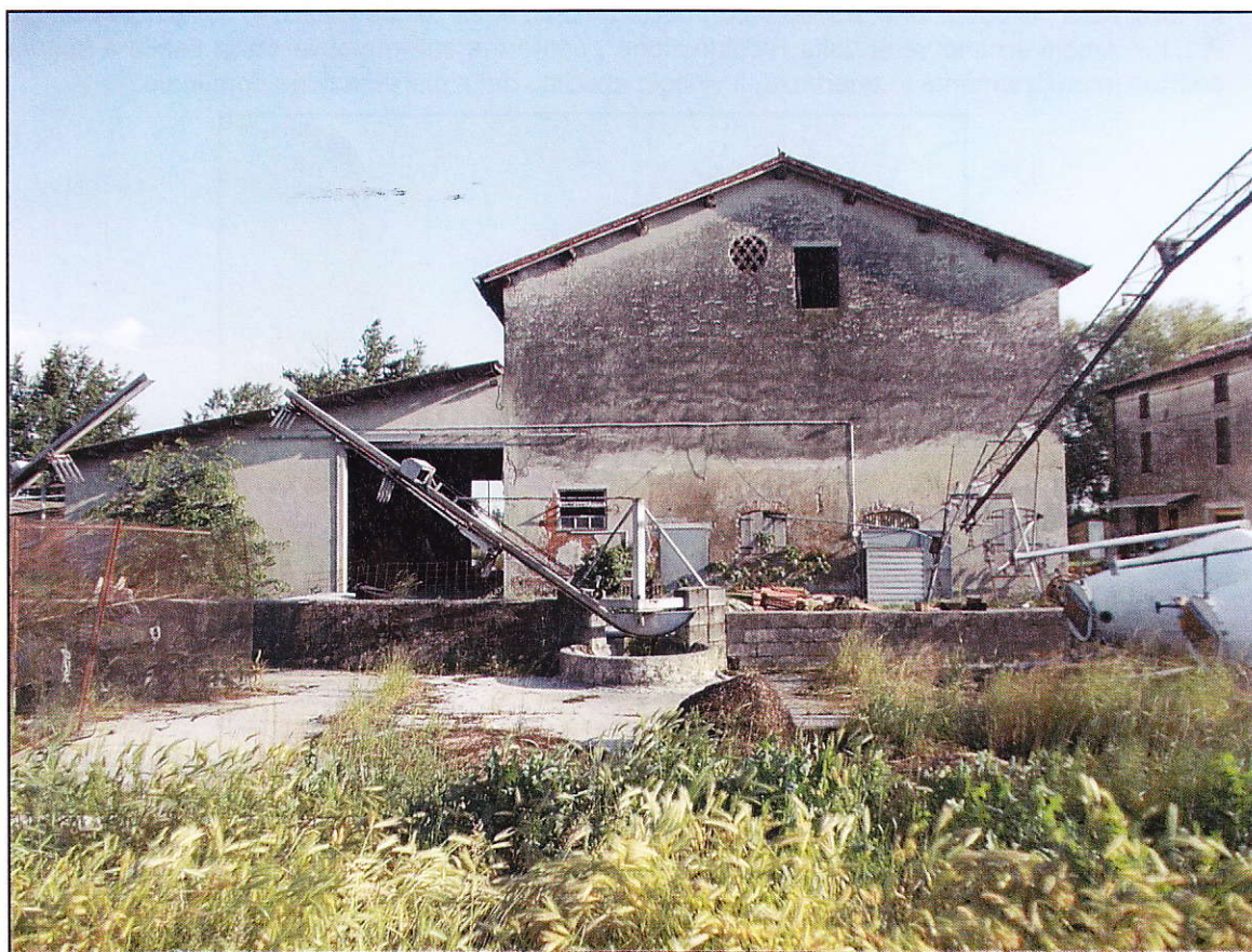
Fig. 4: Ripresa fotografica da nord.
