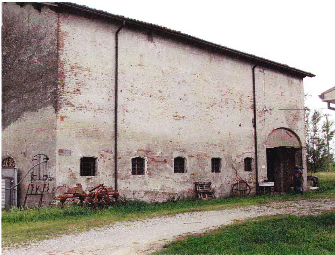
Fig. 5: Ripresa fotografica da nord ovest.
