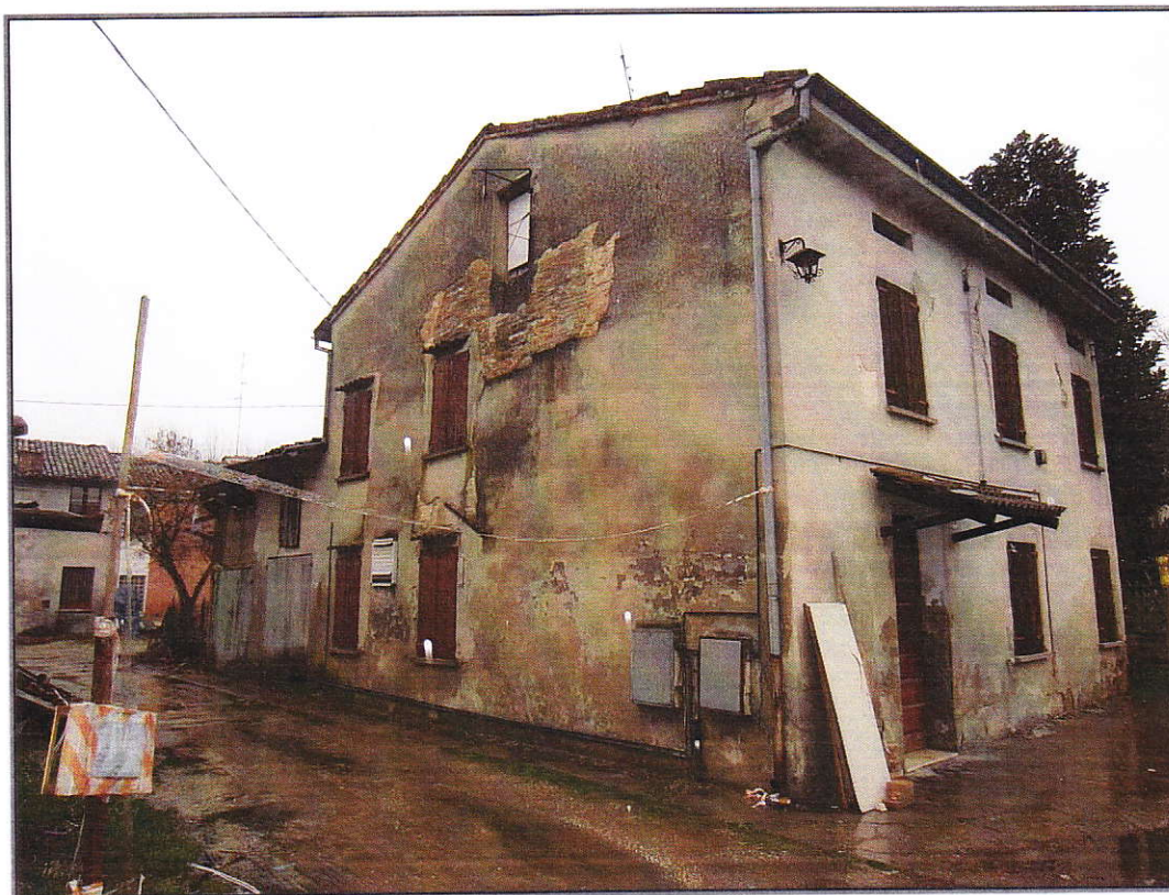
Edificio oggetto di demolizione
