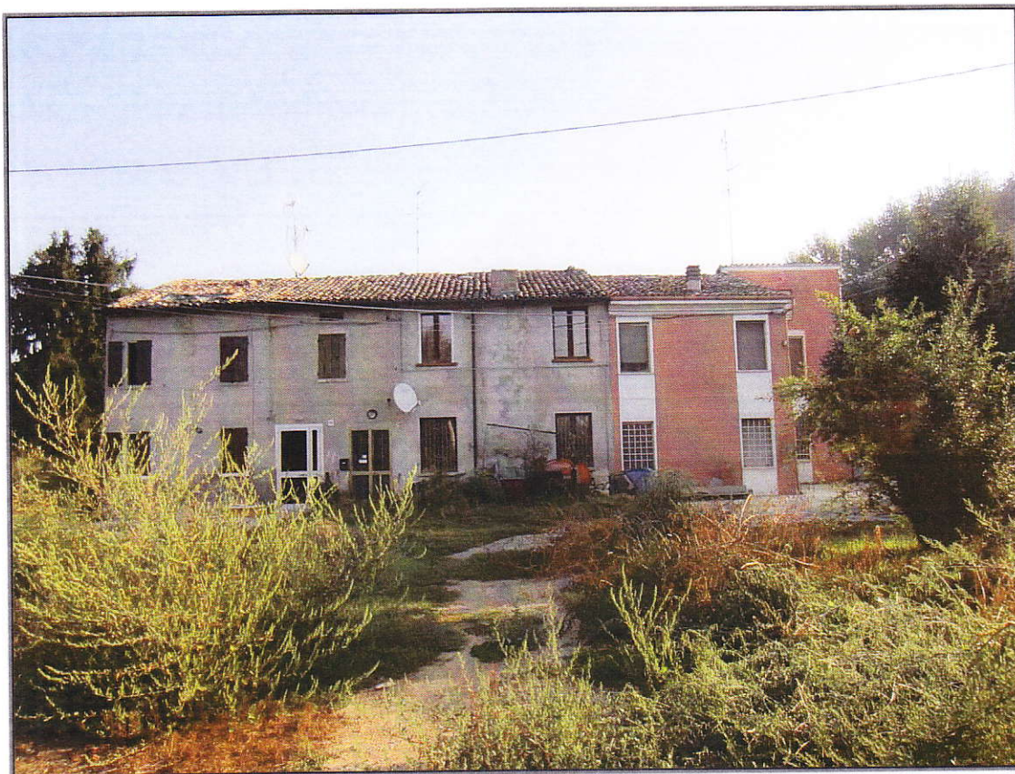
Area mappale 148 dopo la demolizione
