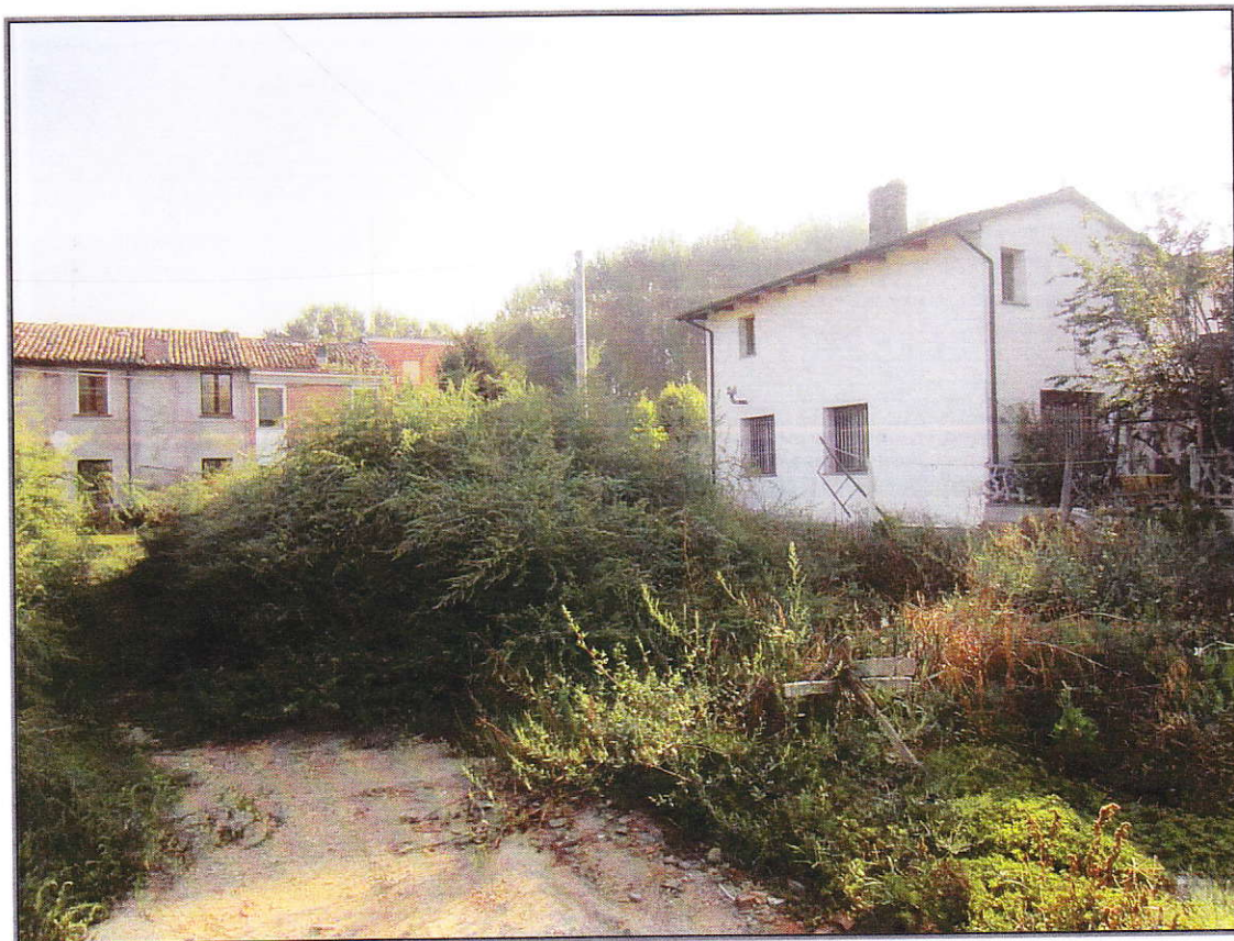
Area mappale 148 dopo la demolizione
