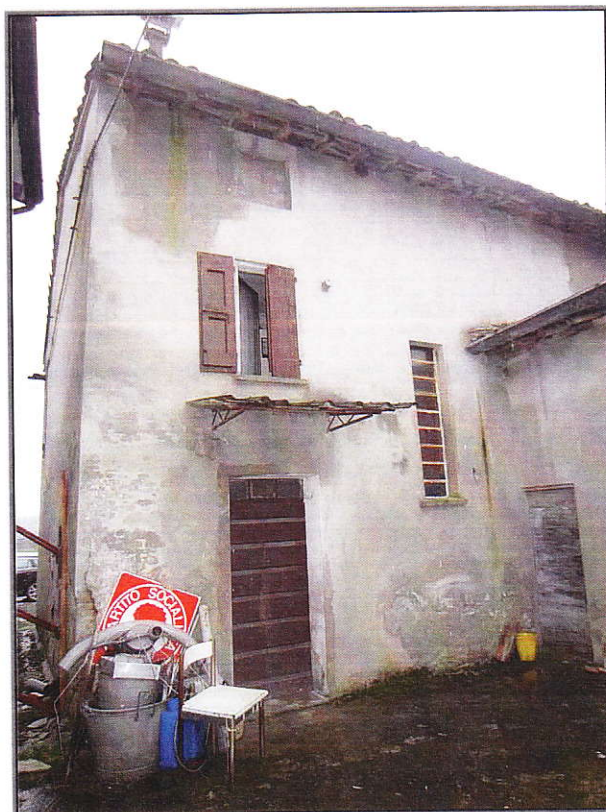
Edificio oggetto di demolizione
