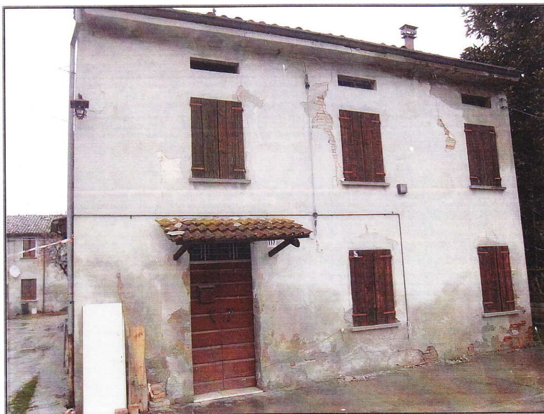
Edificio oggetto di demolizione
