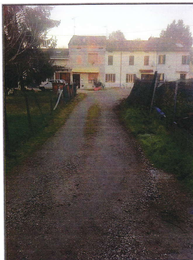
Vista dell'attuale via interna posta sul mappale 299 a confine con i mappali 129, 130, 131
