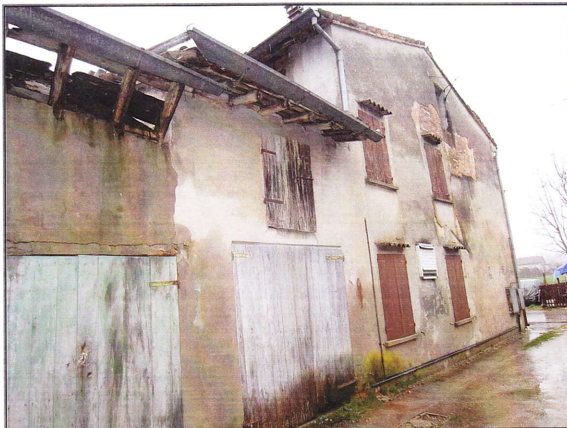
Edificio oggetto di demolizione
