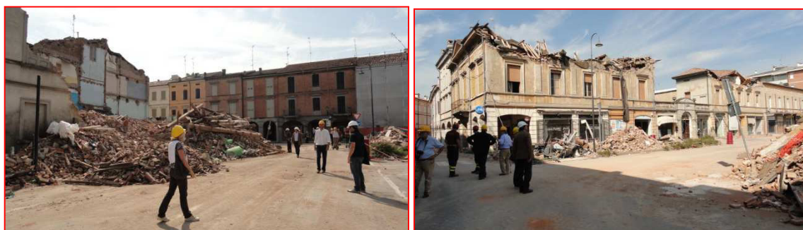
Fig. 12 Il grande guasto alla radice di viale Garibaldi. A destra il crollo del palazzo Mari; a sinistra i danni alle strutture parrocchiali.
